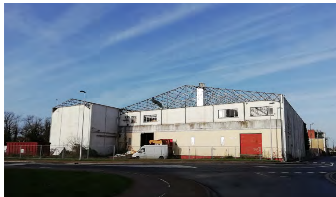
Redon (35) – Reconversion d'une friche logistique - Crédit photo : EPF Bretagne
