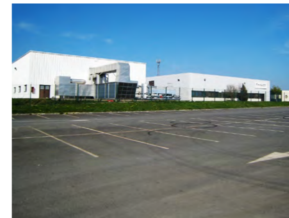
Châteaubourg (35) – Restructuration et réaménagement du site Thales en lots autonomes - Crédit photo : EPF Bretagne
