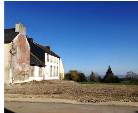
Laz (29) – Chantier de démolition-reconstruction Crédit photo : EPF Bretagne
