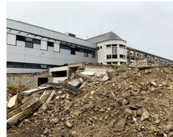
Pontivy (56) – Déconstruction d'une friche hospitalière Crédit photo : EPF Bretagne
