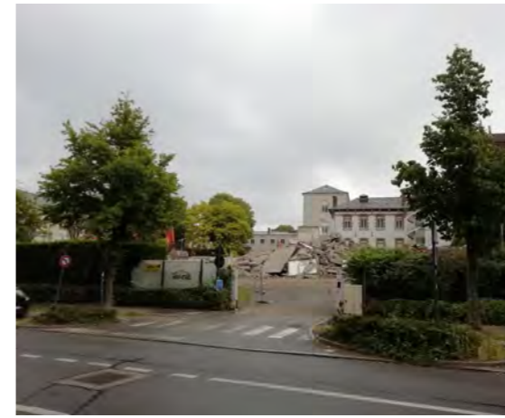
Rennes (35) – Démolition de l'Hôtel-Dieu Crédit photo : EPF Bretagne
