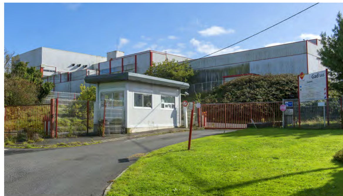
Lampaul-Guimiliau (29) – Friche industrielle du site GAD – Crédit photo : EPF Bretagne
